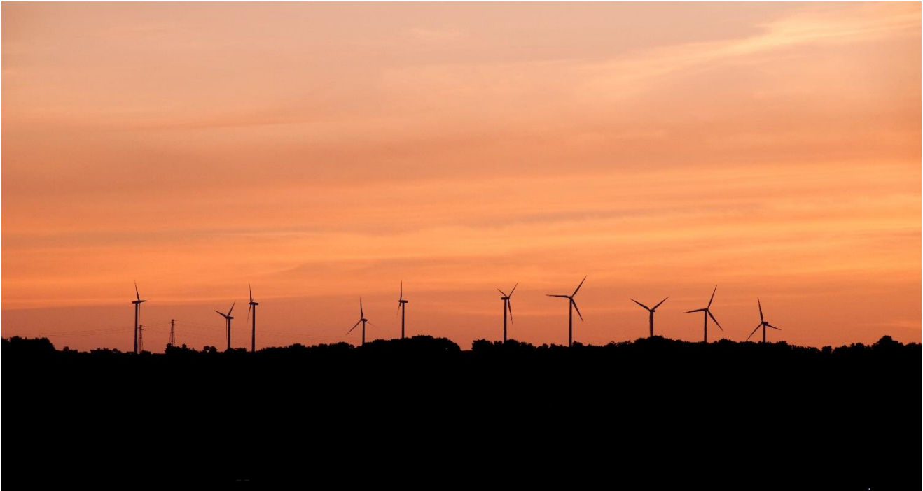
Parco eolico di Albanella
