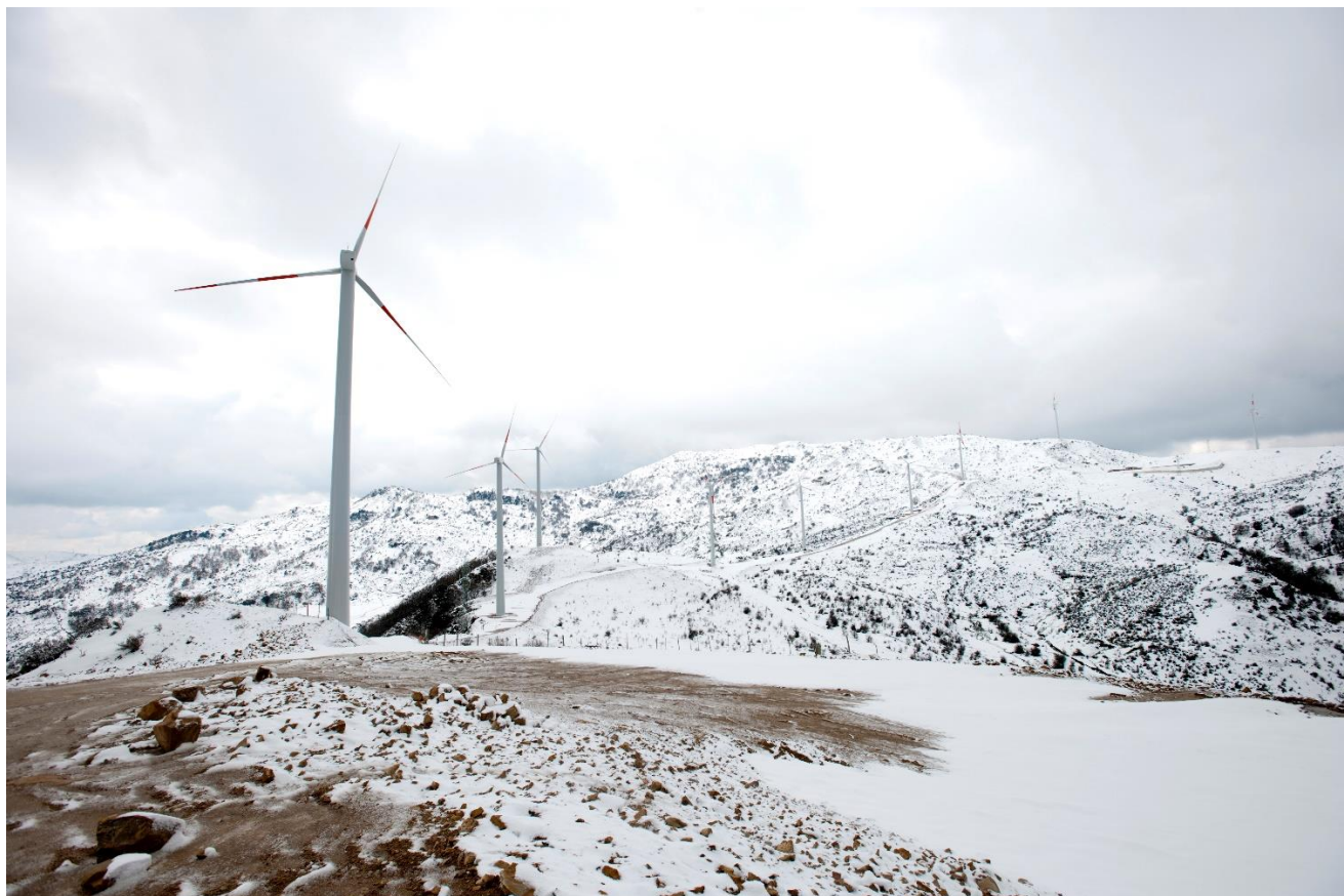
Parco eolico di Castel di Lucio
